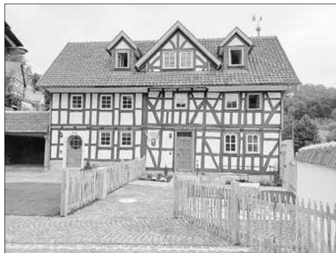
Das ehemalige Kurmainzer Forsthaus in der Diedorfer Straße 11 in Wendehausen erstrahlt nach umfassender Sanierung in neuem Glanz.
