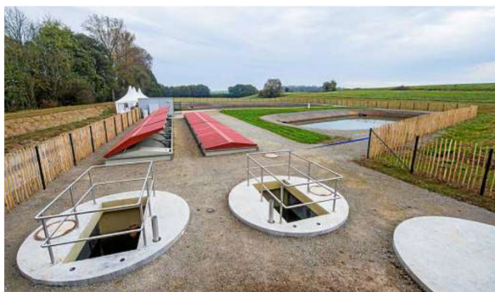
Die geplante Kläranlage in Wendehausen entspricht der 2017 eingeweihten Kläranlage Schildbach auf dem Foto.
