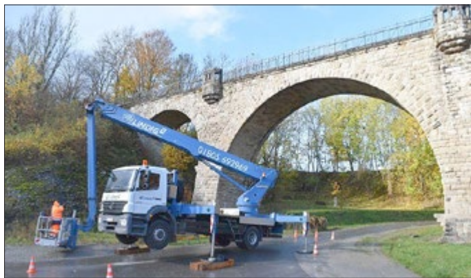
Mit einem Autokran gingen die Bauexperten zu Werke Fotos: Reiner Schmalzl
